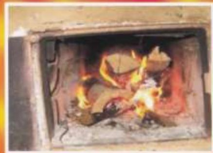
*Печи должны иметь установленные нормами противопожарные разделки (отступки) от горючих конструкций, а также предтопочный лист размером 0,5 x 0,7 м, без прогаров и повреждений*
